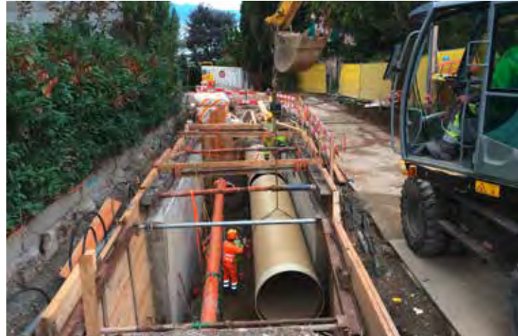
Pose du collecteur de récolte d'eau claire DN 1200 mm et d'eau usée DN 315 mm au ch. de Villardin
