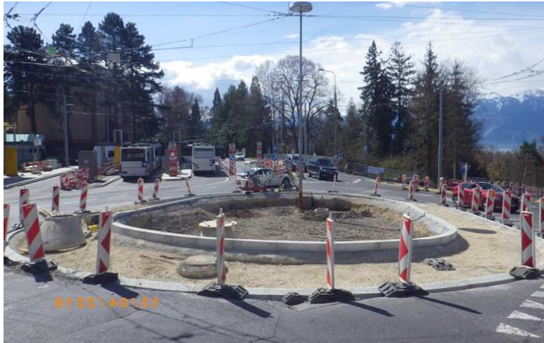
Travaux côté Est du bd de la Forêt
