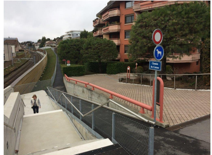
Vue depuis pont av. du Tirage ~ 15.6 %
